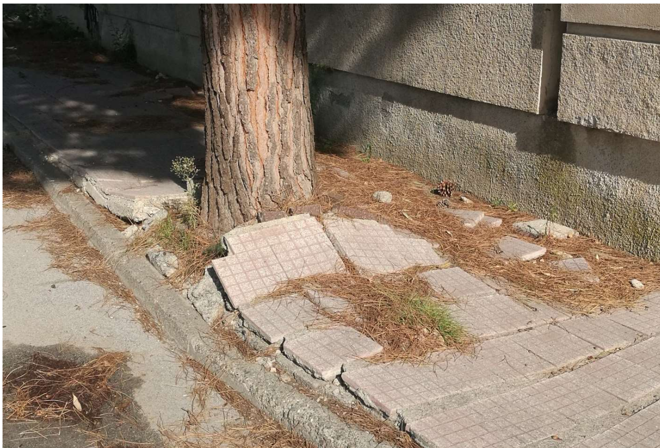
Pavimentazione sollevata dalle radici degli alberi
