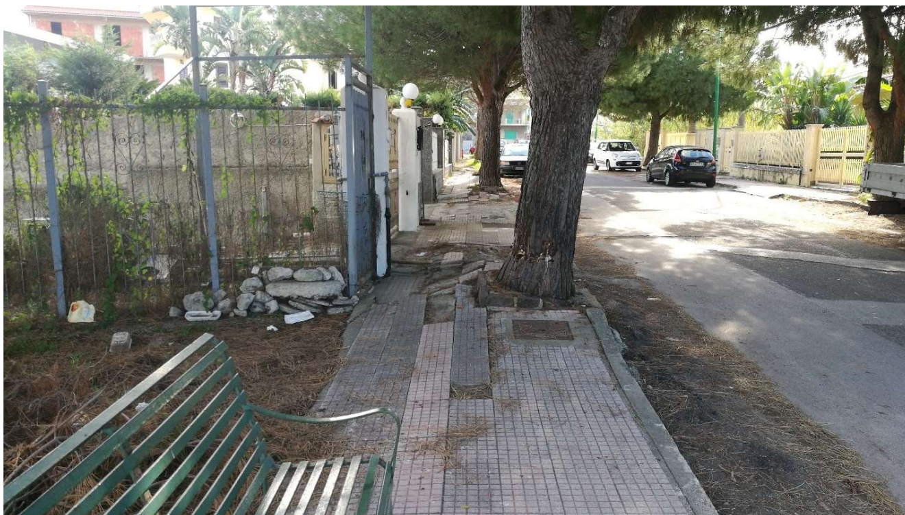
Pavimentazione sollevata dalle radici degli alberi – lato monte
