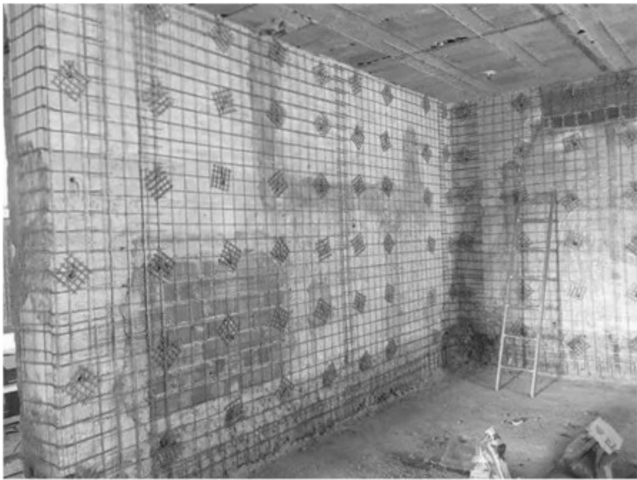
Esempio di rinforzo strutturale per muratura
