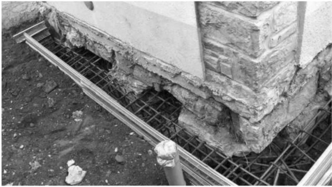
Esempio di allargamento impronta fondazione
