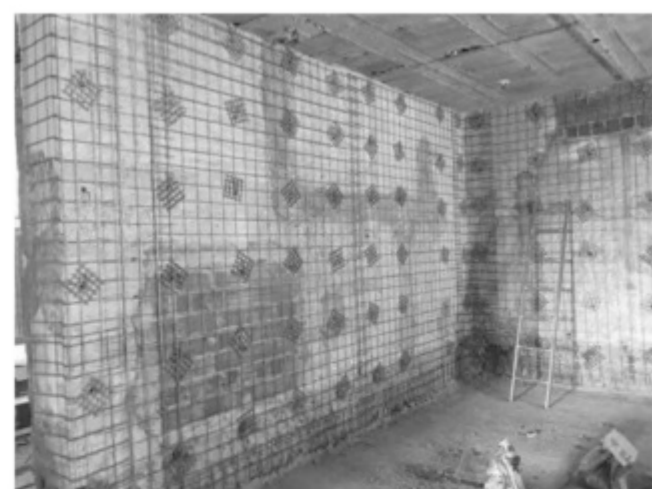
Esempio di rinforzo strutturale per muratura
