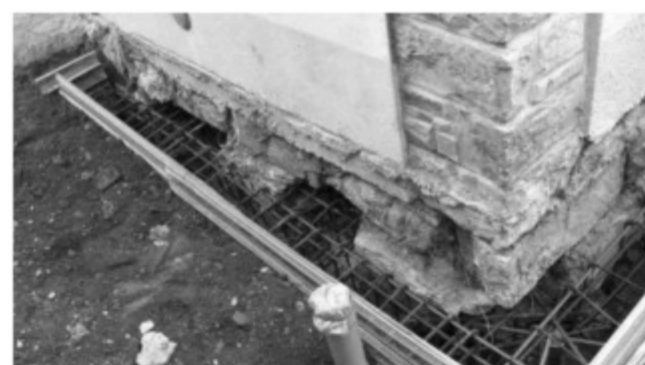
Esempio allargamento impronta Fondazione
