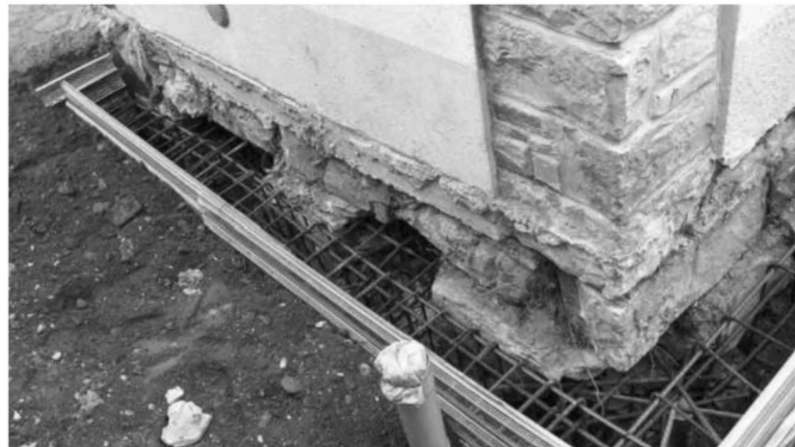
Esempio di allargamento impronta fondazione
