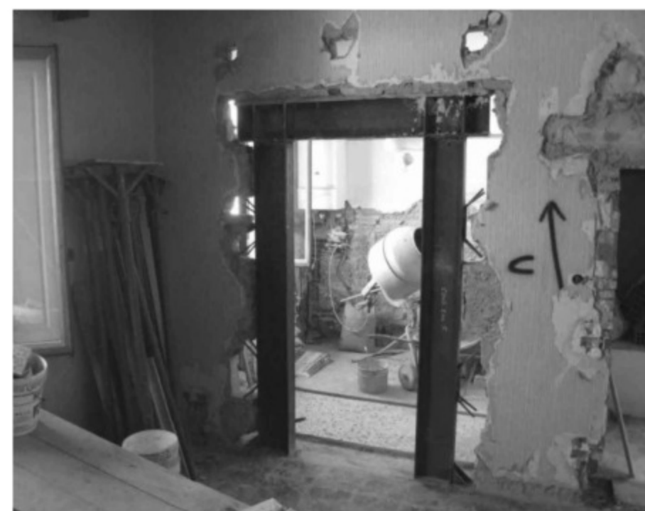
Esempio rinforzo strutturale delle aperture mediante cerchiature
