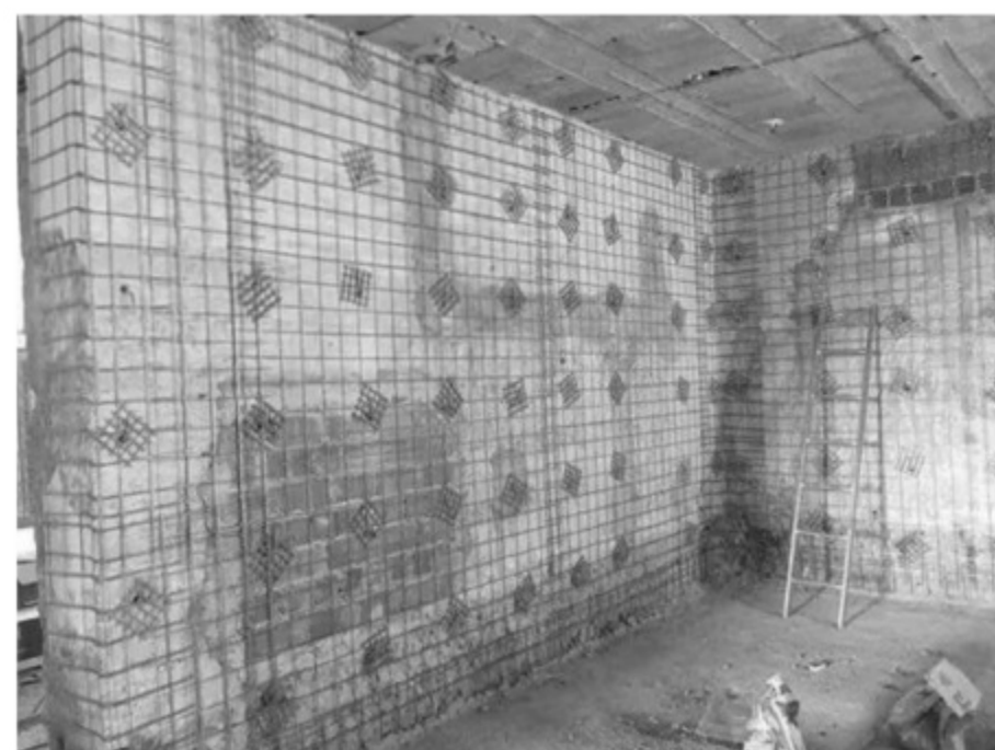
Esempio di rinforzo strutturale per muratura
