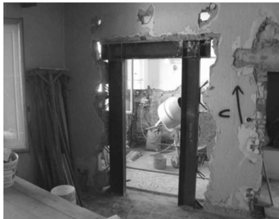
Esempio rinforzo strutturale delle aperture mediante cerchiature
