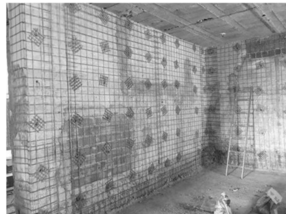
Esempio di rinforzo strutturale per muratura
