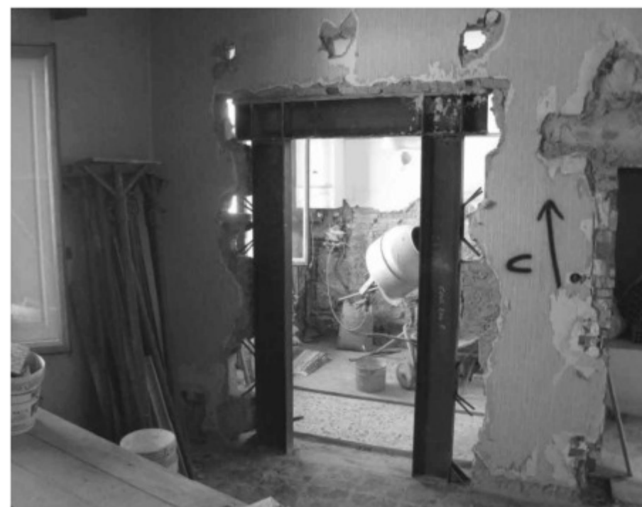
Esempio rinforzo strutturale delle aperture mediante cerchiature
