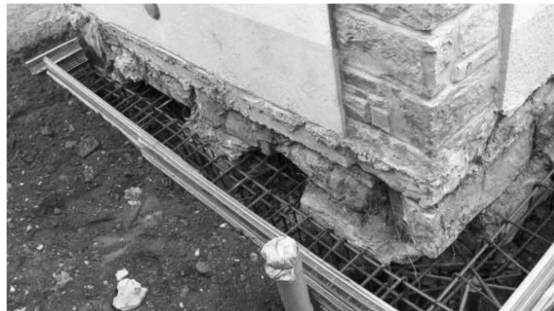
Esempio di allargamento impronta fondazione
