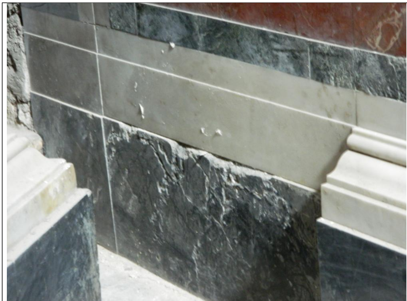
Foto CDX11 – particolare parete dx – fessurazioni e lacune
