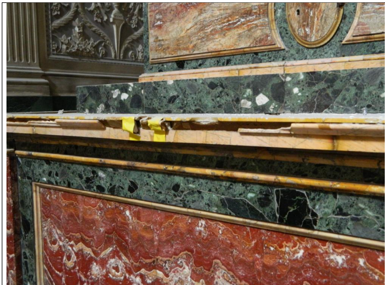
Foto CSX25 – Particolare Altare – Mancanze, fessurazioni, fratture
