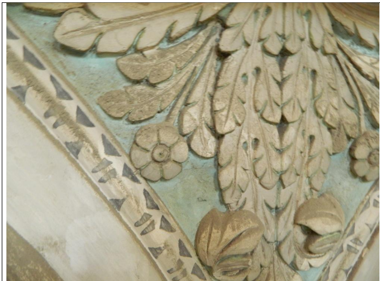
Foto NC9 – particolare spicchi – depositi incoerenti, alterazione cromatica e fessurazioni
