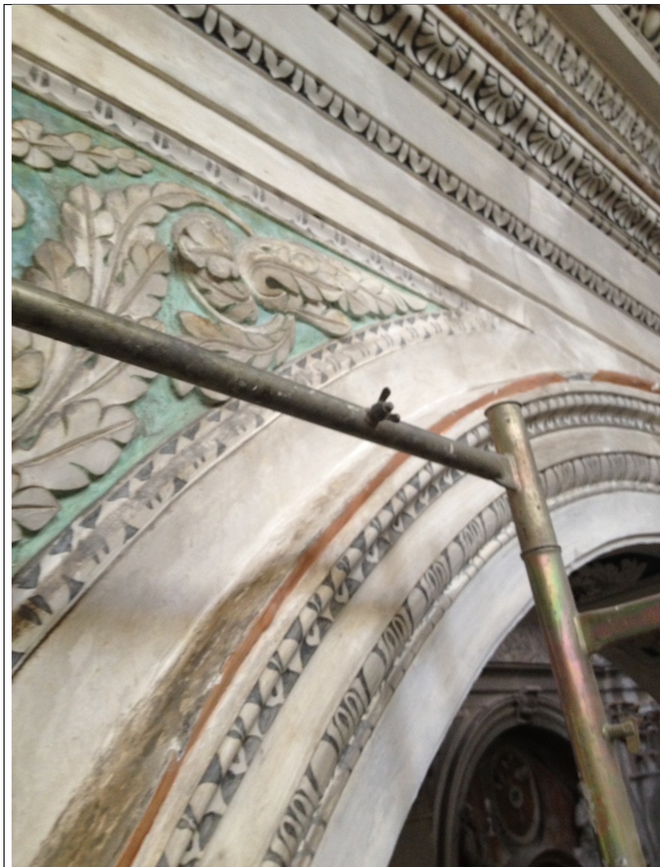
Foto NC6 – particolare alterazione cromatica e fessurazioni
