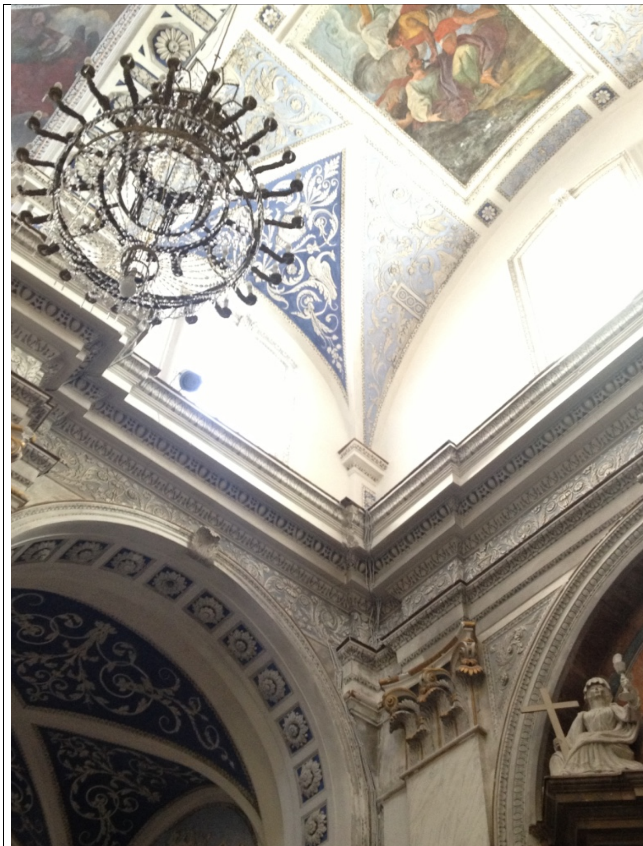
Foto TR6 particolare lato sx –fessurazioni angoli e mancanza dorature capitelli paraste
