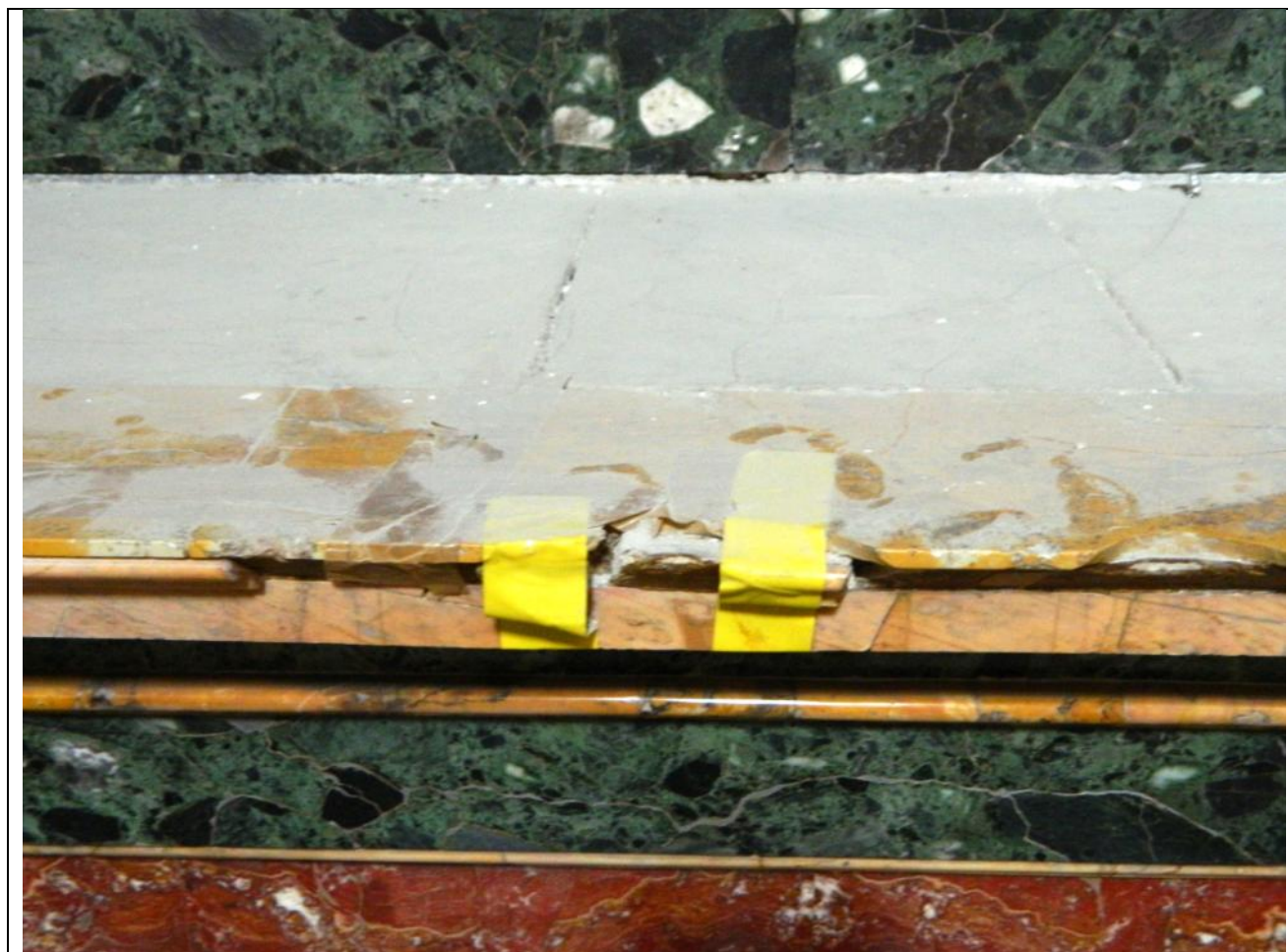
Foto CSX24 – Altare - Gradino in marmo con fratture e fessurazioni
