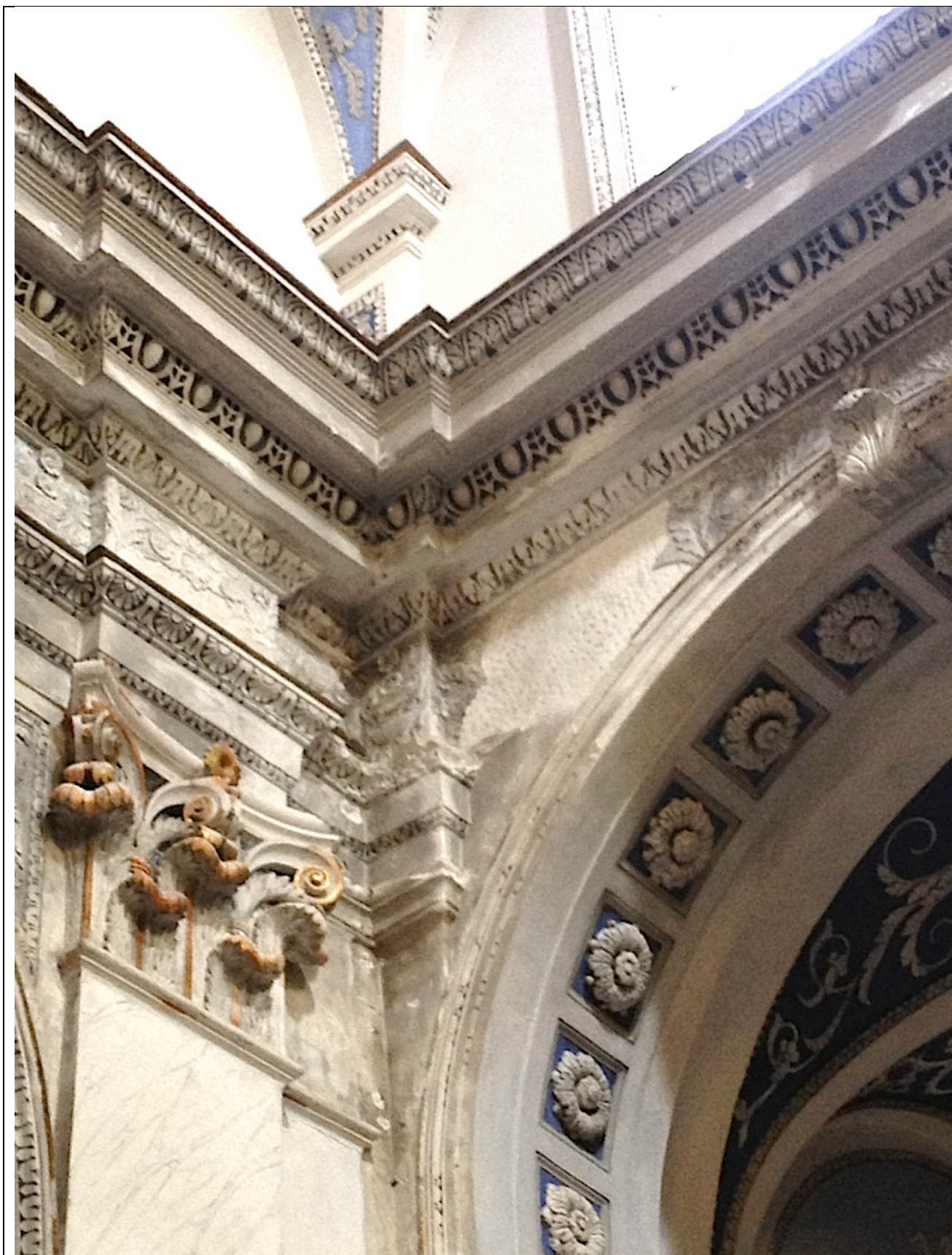
Foto TR9 - particolare lato dx -distacchi, fessurazioni, lacune e depositi
