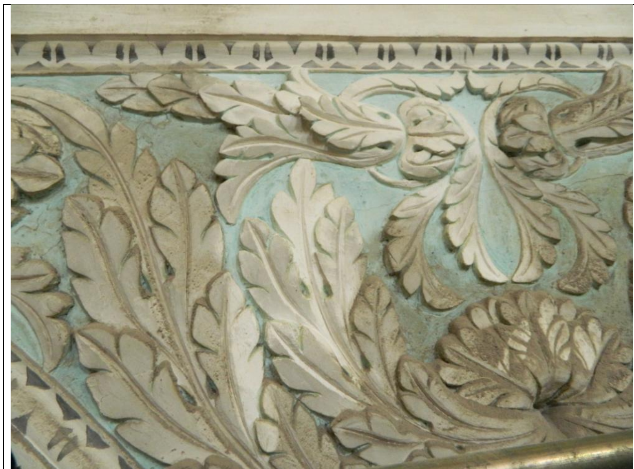
Foto NC5 – particolare fregio – depositi incoerenti e fessurazioni
