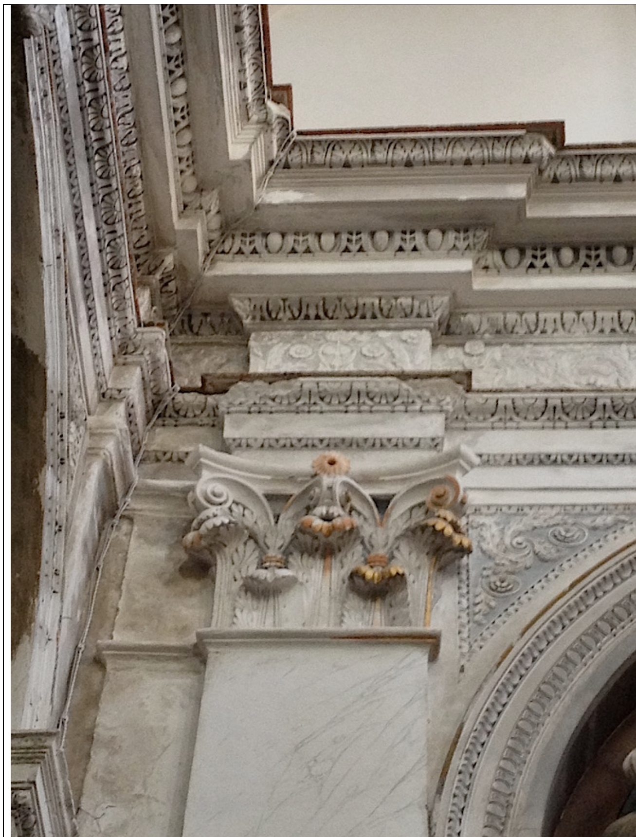
Foto TR10 – particolare lato dx – lacune diffuse e alterazione cromatica
