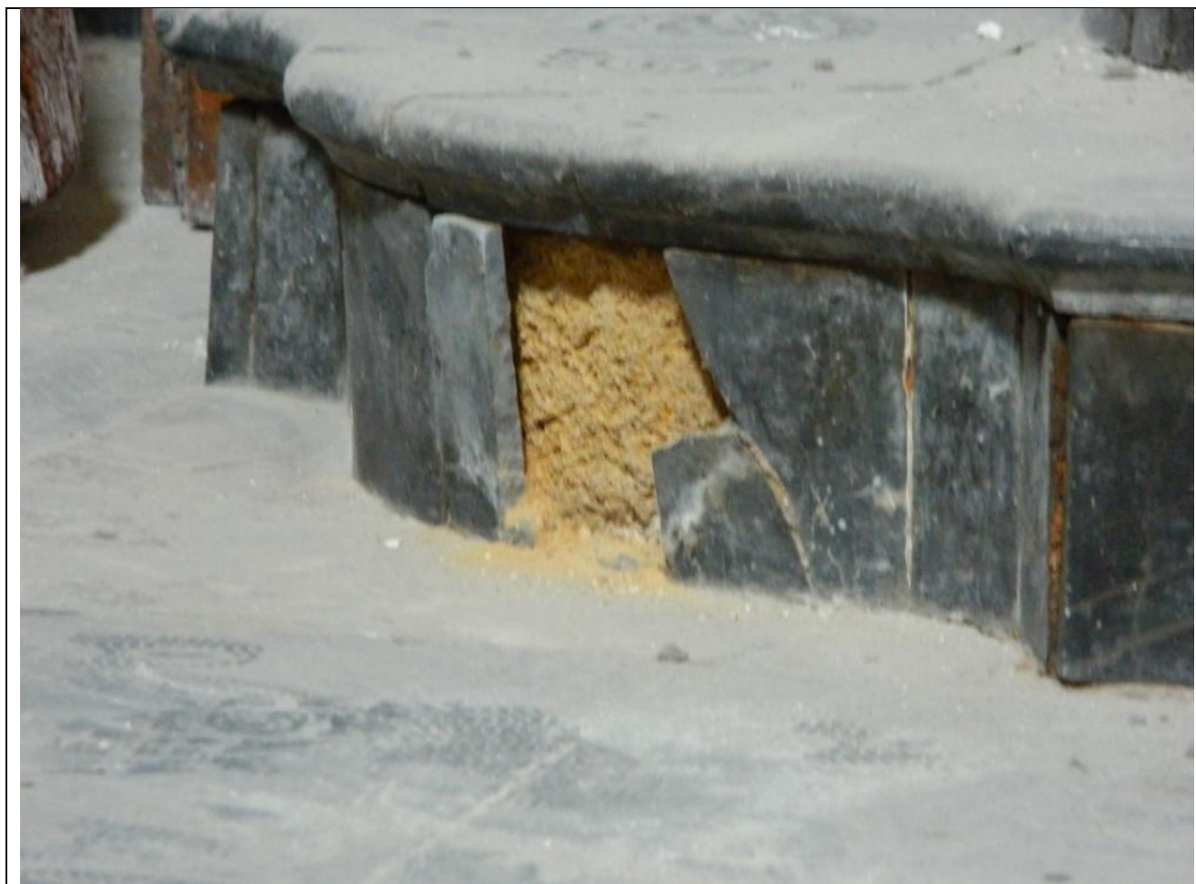
Foto CDX9 – Particolare gradino altare – disconnessioni, distacchi e lacune
