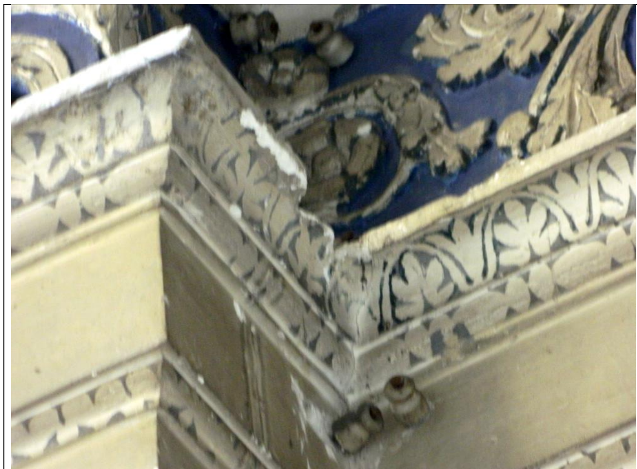
Foto CSX7 – Particolare angolo – Fessurazioni - Lacune
