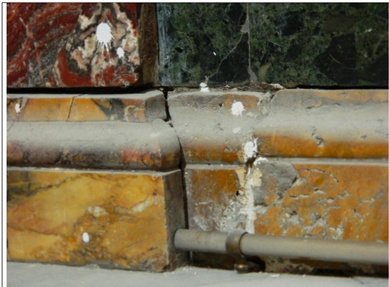
Foto CSX19 – Particolare base altare – Fessurazioni, disconnessioni, depositi incoerenti
