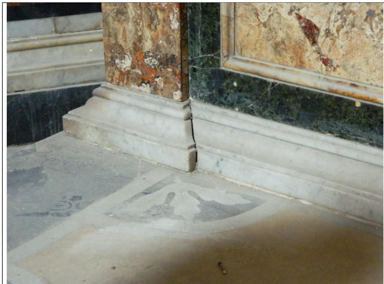
Foto CDX7 – Particolare Base Altare – Distacchi e fessurazioni
