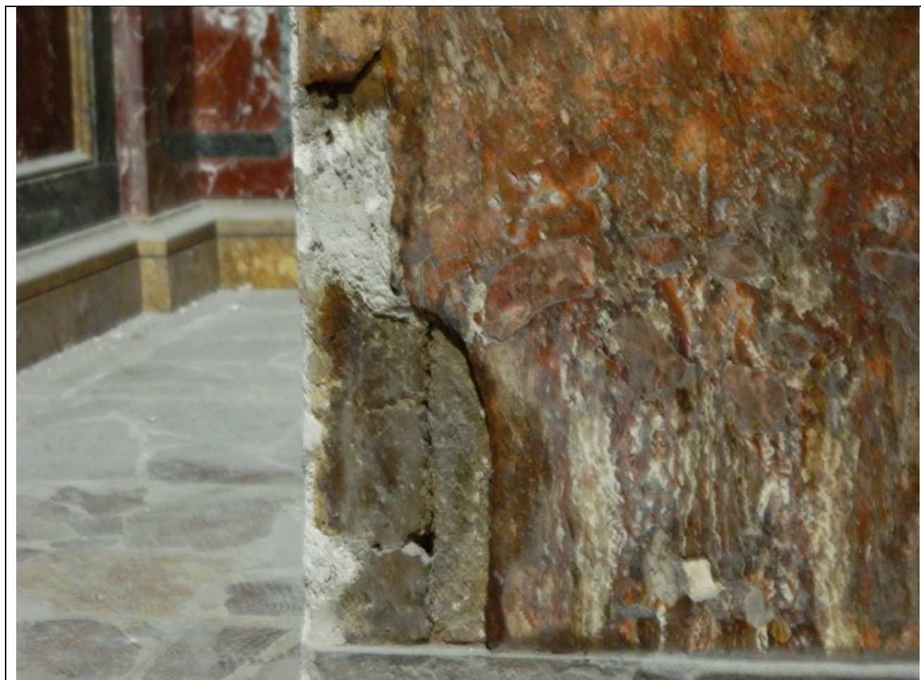
Foto CSX22 – Particolare altare - Fessurazioni
