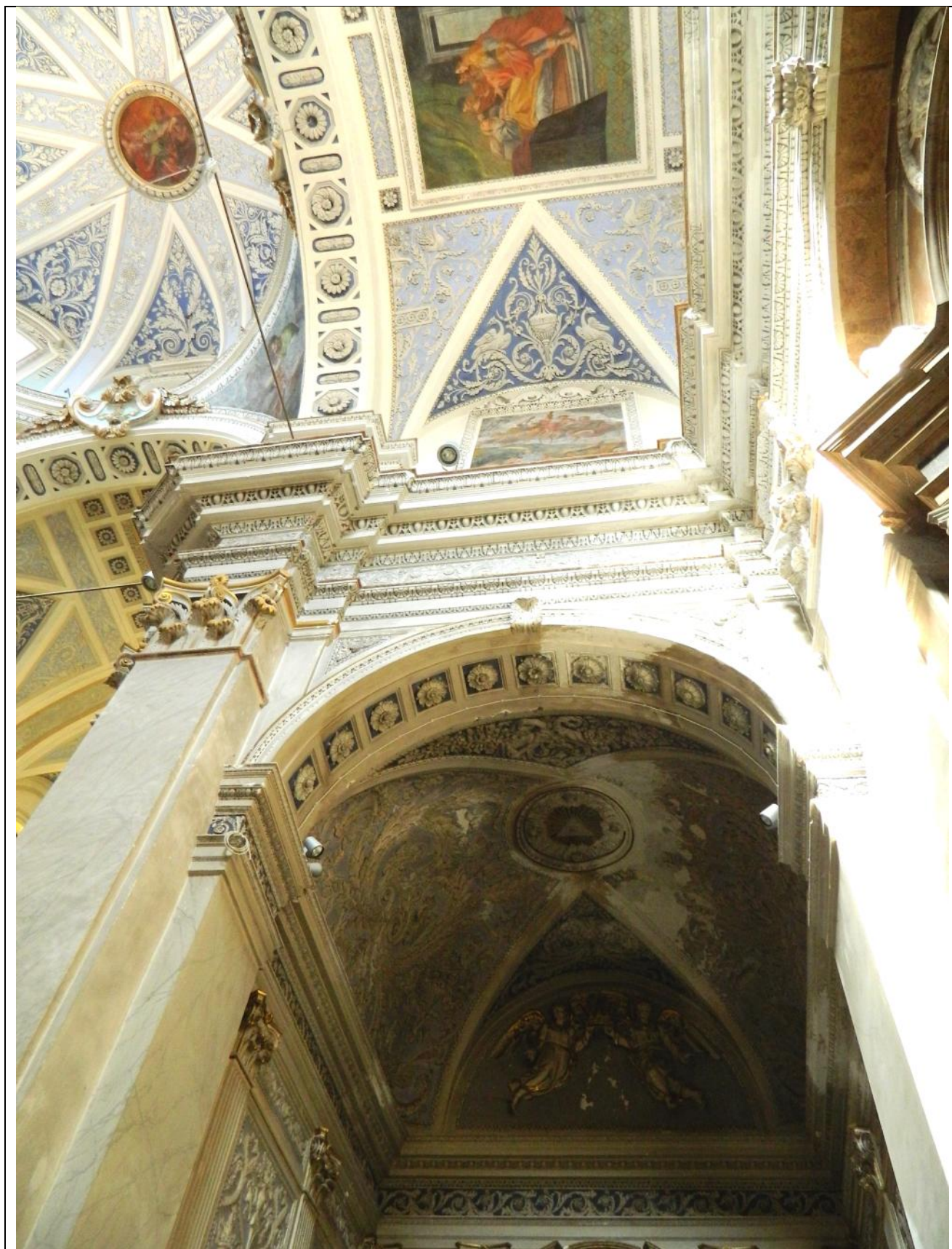
Foto CSX4 – Soffitto alterazione cromatica – perdita stucchi
