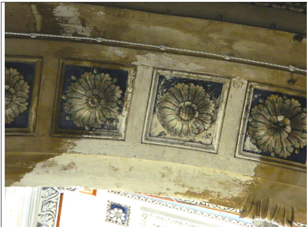
Foto CSX3 – Soffitto alterazione cromatica fessurazioni – perdita di colore
