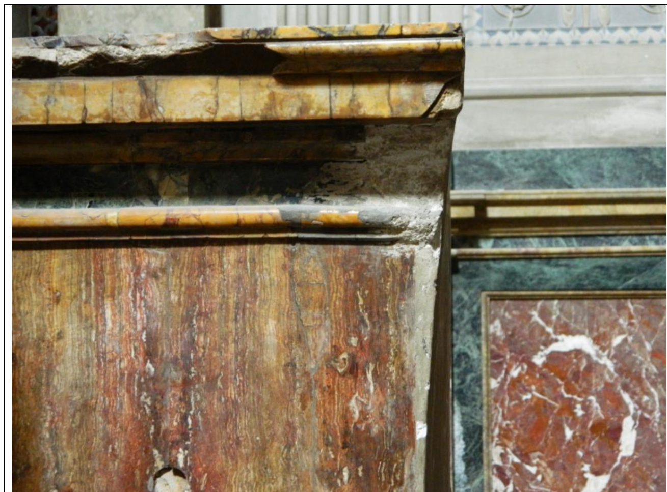
Foto CSX21 – Particolare altare – Distacchi e abrasioni
